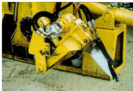
Rys. 6.12. Widok końcówki CRAFT® wykonującej rowek i wypełniającą go emulsją asfaltową [7].
