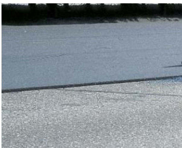
Rys. 6.19 Specjalna warstwa z drobnoziarnistej MMA ułożona w czasie remontu nawierzchni [40]
