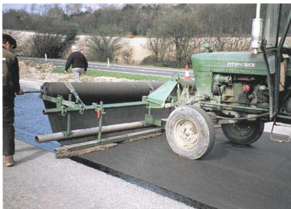
Rys. 6.20. Układanie geowłókniny na powierzchni skropionej emulsją asfaltową.
