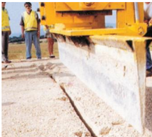
Rys. 6.5. Nóż wibracyjny do wykonania rowka w metodzie „joint-actif”® [19]
