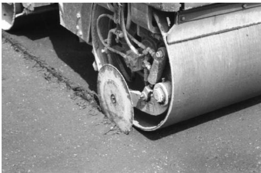
Rys. 6.10. Formowanie rowka w świeżo zagęszczonej warstwie związanej spoiwem z zastosowaniem tarczy mocowanej do walca [7].
