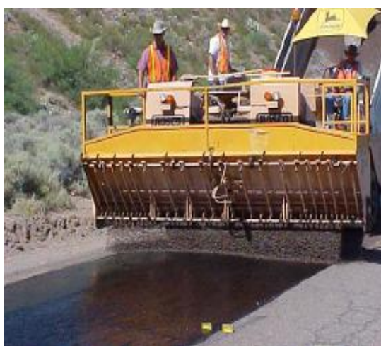
Rys 6.18. Wykonane warstwy SAMI.
