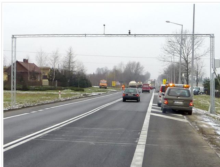
Rys. 2.2.2. Stacja WIM w Woli Dębińskiej w ciągu DK4 (mat. firmy Neurosoft ) Lokalizację punktów pomiarowych uwzględnionych w opracowaniu przedstawiono na rys. 2.2.3. W analizie uwzględniono łącznie 5 stacji obsługiwanych przez firmy Neurosoft i Cat-traffic :
