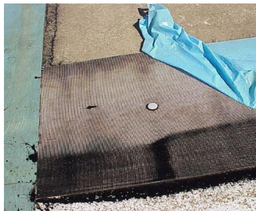
Rys. 6.21. Przykład specjalnego kompozytu ISAC do przeciwdziałania spękanom odbitym.
