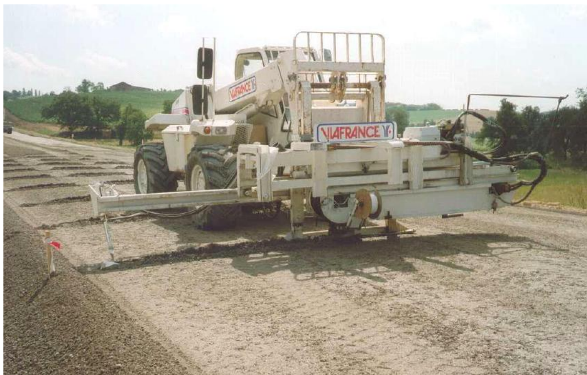
Rys. 6.8. Maszyna do wykonywania szczelin w technologii OLIVIA® [7].
